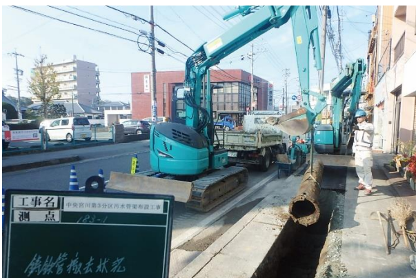
老朽管撤去状況
